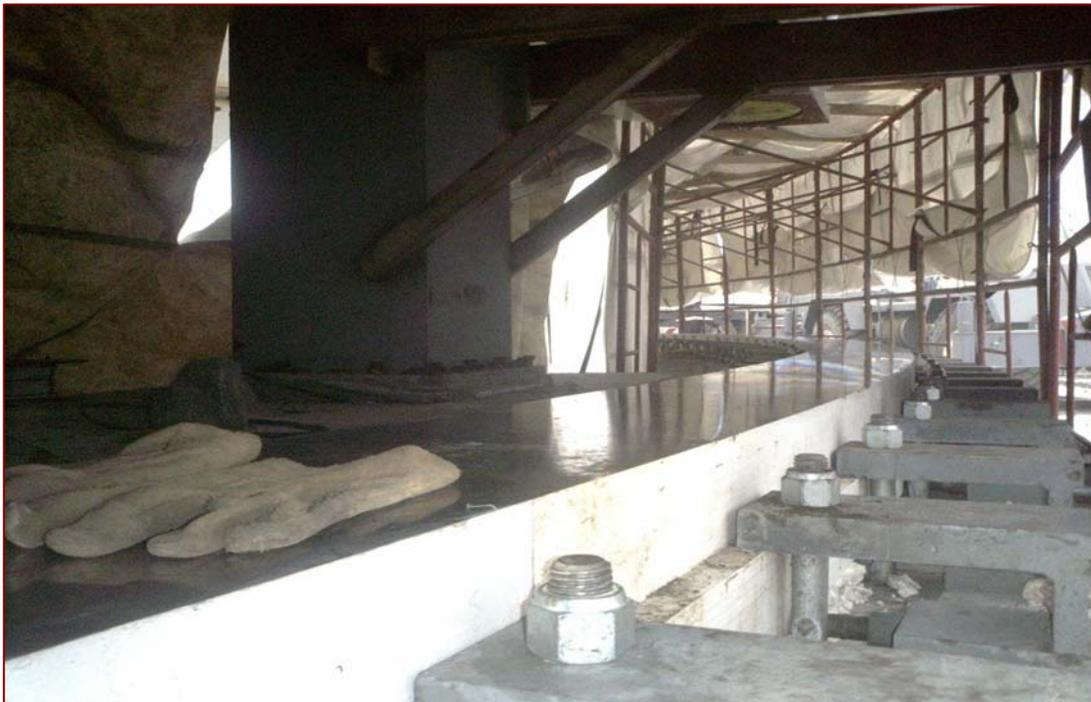
*La pista de rodamiento instalada, en proceso de alineación final. A la derecha una de las uniones reparada.*
